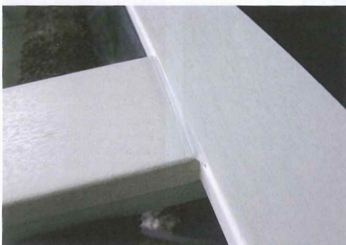
Füllen der V-Fugen vor der Endlackierung mit Induline AF-920.
