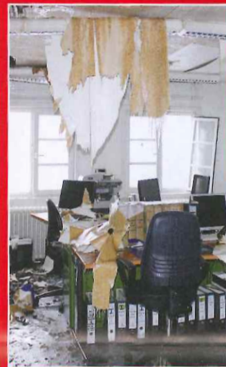
Schäden durch Löschwasser
